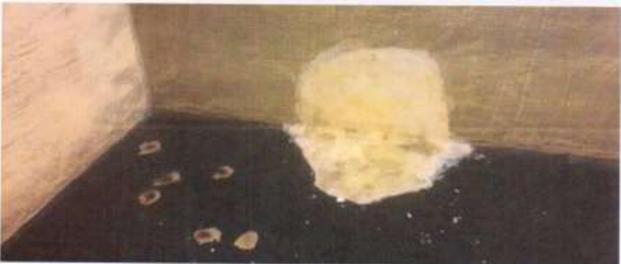
Abbildung 6: 2.07 Zustand vom Boden in der Trinkwasserkammer rechts
