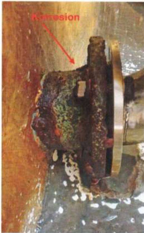
Abbildung 10: 2.06 Zustand der Rohre und Halterung in der Trinkwasserkammer
