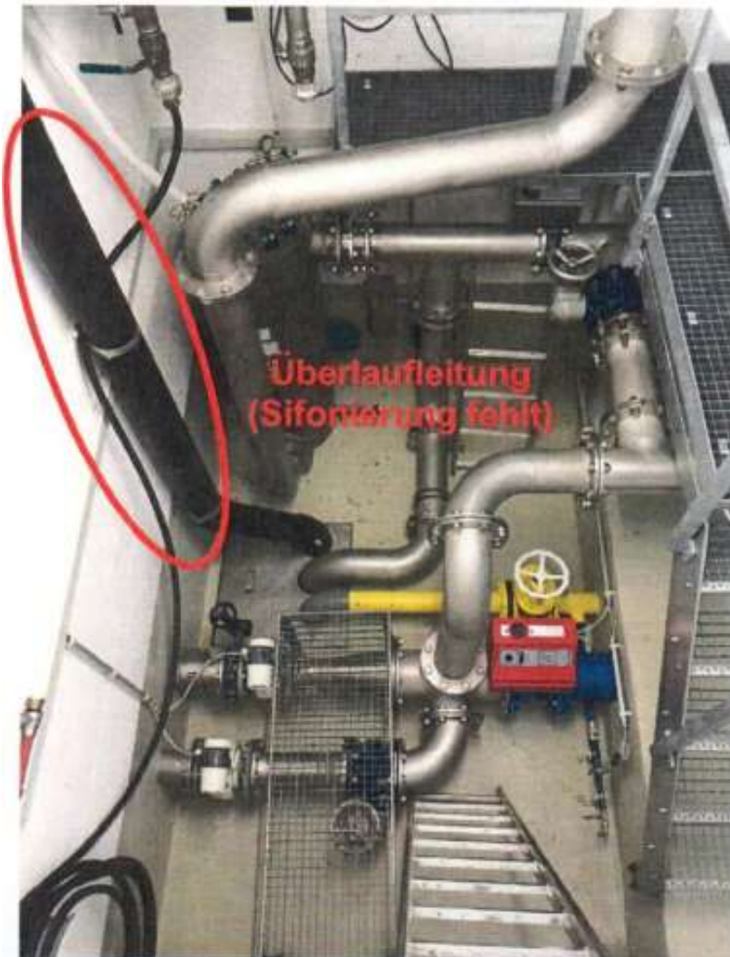
Abbildung 16: 2.12 Überlauf Wasserkammer
