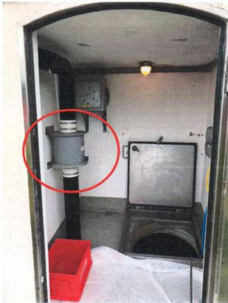
Abbildung 12: 2.11 Belüftung Trinkwasserkammer
