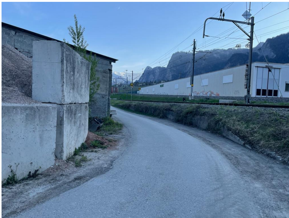
Abb. 3: Oberauweg, Blick Richtung Norden (R+K, April 2022)
