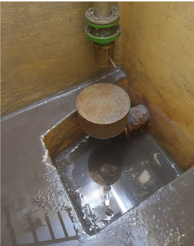
Zustand der Wasserentnahme in der Trinkwasserkammer "Teufelsfriedhof"
