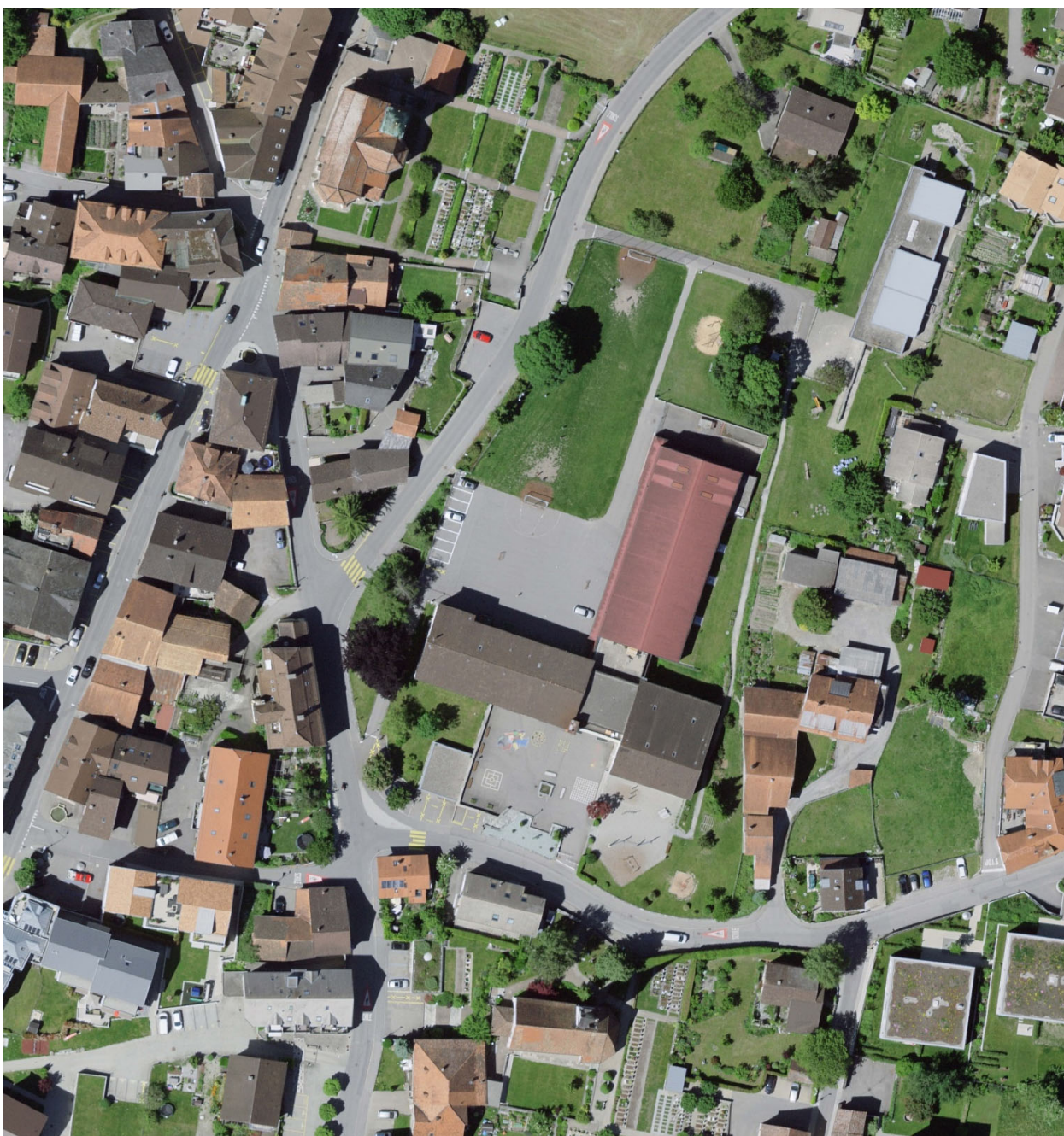
Luftbild Schulanlage Obergasse, Zizers
